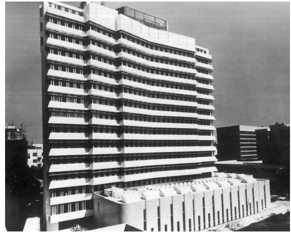
Geschäftshaus Bank Sabbag in Beirut, Libanon, 1967: Der 15-geschossige Gebäudekomplex liegt an der wichtigsten Geschäftsstrasse von Beirut, der Rue Hamra, und beinhaltet auch Läden, Restaurants und ein Kino.
