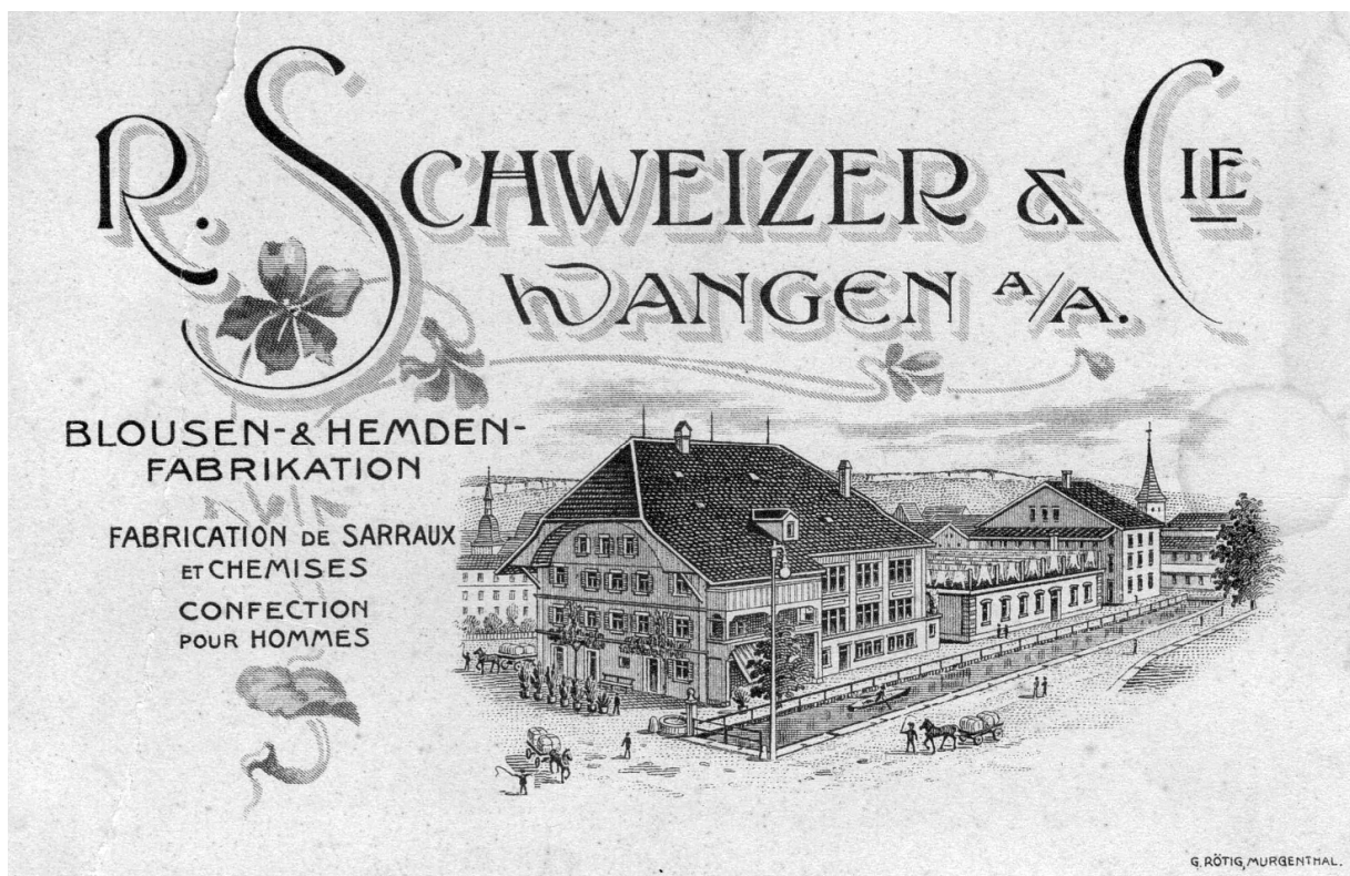
Wohnhaus und Fabrikgebäude Vorstadt 3 – Visitenkarte ca. 1890
