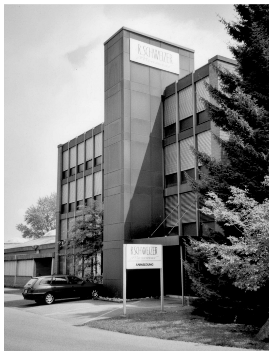
Neues Bürogebäude hinter dem Bahnhof an der Zeughausstrasse Nr. 19
