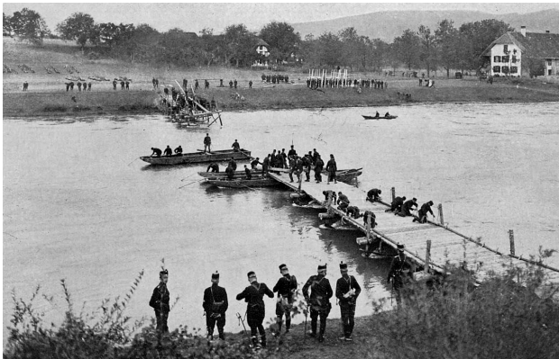
Links sind die Pontoniere an einem anderen Ort am Brückenbau, welcher sich rechts als erfolgreich herausstellte.
