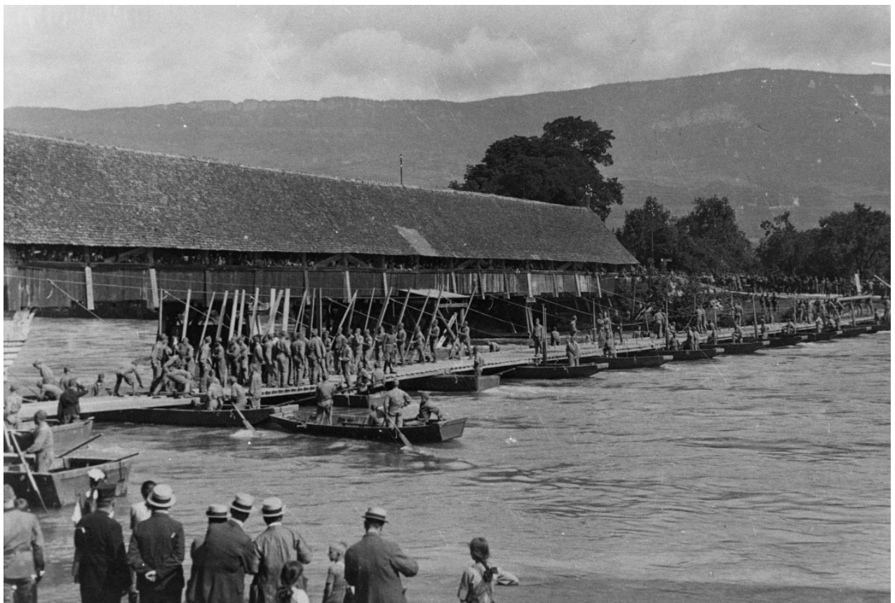
Pontoniere haben neben der Wangerbrücke eine Brücke zu Übungszwecken unter vielen Schaulustigen erstellt. Foto aus der Sammlung Adolf Roth.
