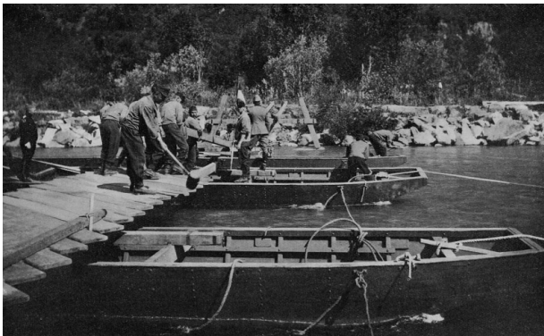
Divisionsbrückentrain 3. Kommandant: Hauptmann Schürch. Brückensteg mit schwimmenden (Pontons) und festen (Böcken) Unterstützungen. Einbau der Pontons. Bau eines 72 m langen Brückensteiges für Infanterie und leichte Fuhrwerke.
