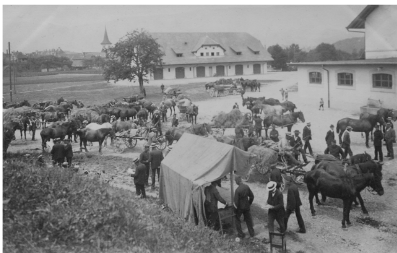
1915. Aufnahme vom Bahnbord. Rechts am Rand das ältere Zeughaus 1 von 1906/07, rechts vom Kirchturm das neuere Zeughaus 2, bezogen 1915. Rechts vorne wäre die Bahnunterführung. Die Fortsetzung ist im unteren Bild der vorhergehenden Seite zu sehen.
