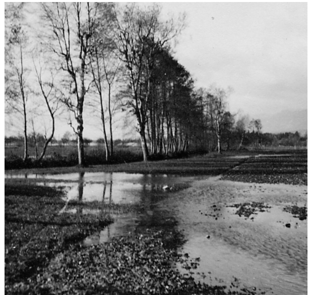
Die noch zu hohe Sohle der Oesch liess zu wenig Wasser ablaufen, oft gabs Überschwemmungen.
