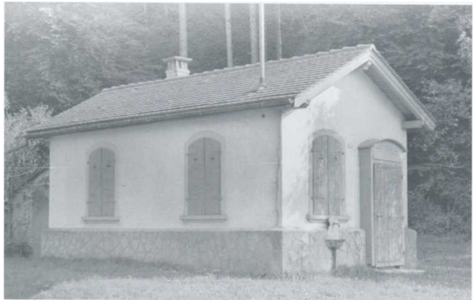
das alte Pumpenhaus
