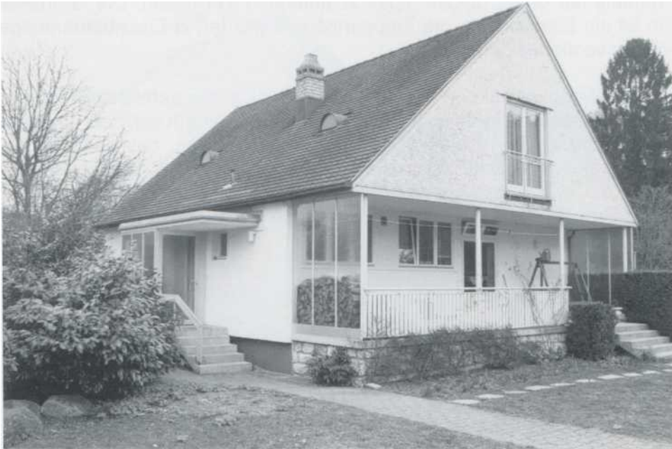
Das Haus für Gottfried Kurt an der Friedbergstrasse
