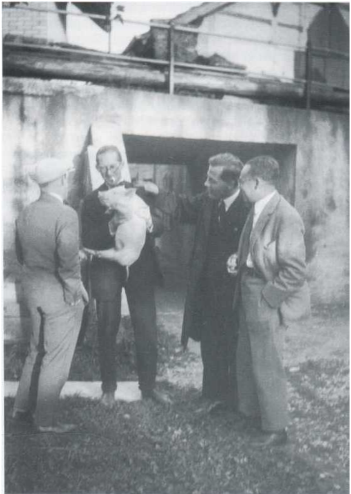
Prominenter Besuch in Wangen a.A., v.l.n.r.: Pierre Jeanneret, Le Corbusier, Sigfried Giedion und Friedrich Gubler
