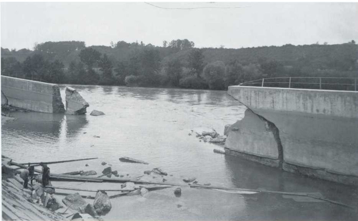
Fahrhöfli, Bruch der Kanalmauer, 10. August 1905
