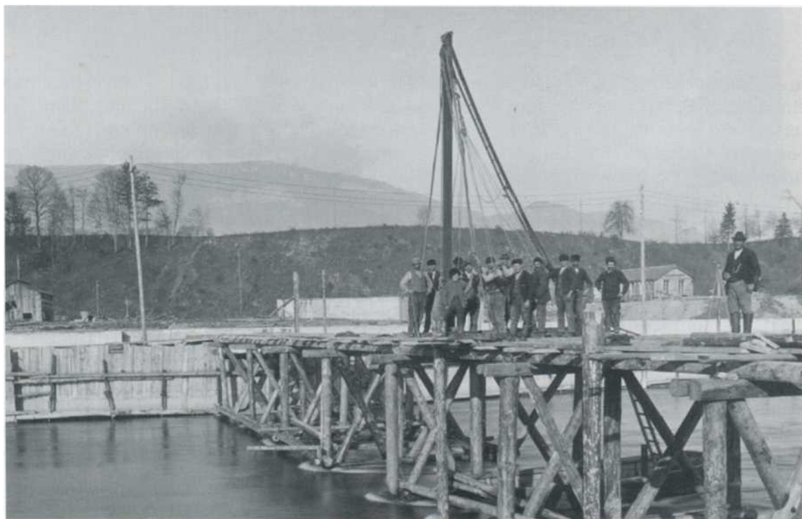
Stauwehr, Arbeiten mit der Handramme 12. Januar 1901
