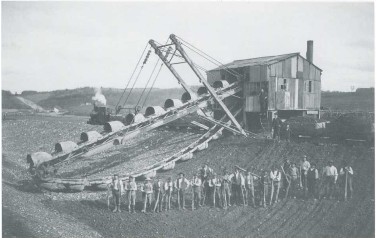
Kanal, Dampfbagger mit Mannschaft
