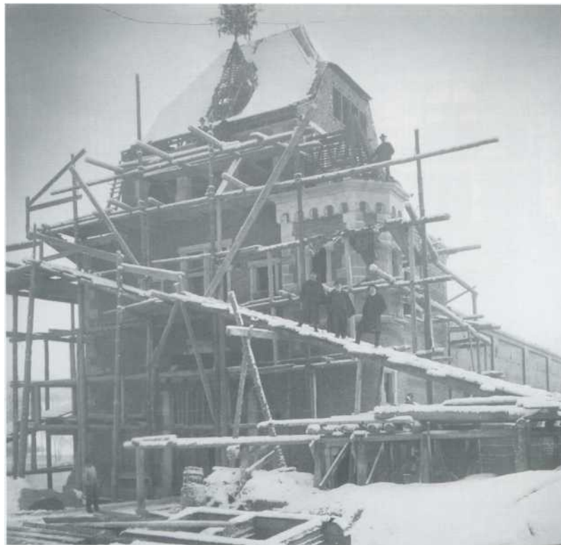
Maschinenhaus, Aufbau aufgerichtet 18. Januar 1904
