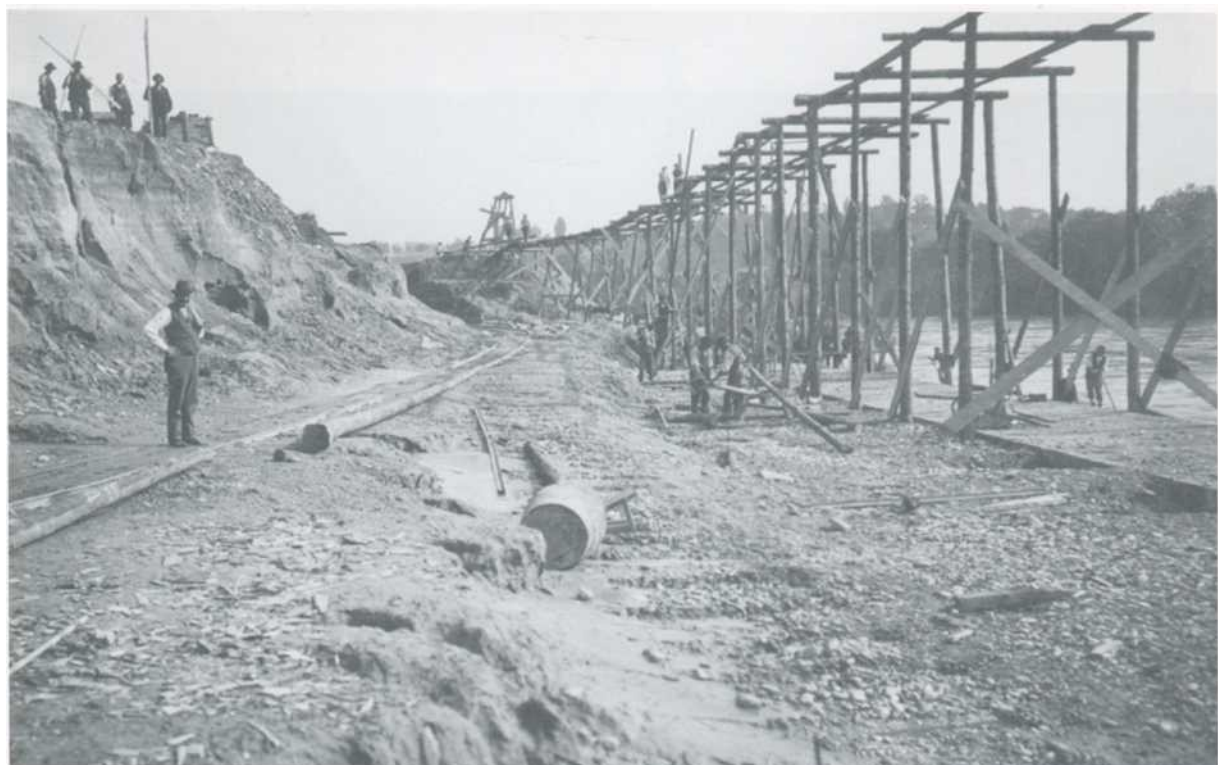
Kanal, Gerüst zur Einschalung der Kanalmauer im Fahrhöfli 27. September 1901
