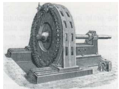
160 kW Drehstromgenerator von Brown für die Lauffen-Frankfurt-Uebertragung 1891 (Bull. SEV 9/1989)
