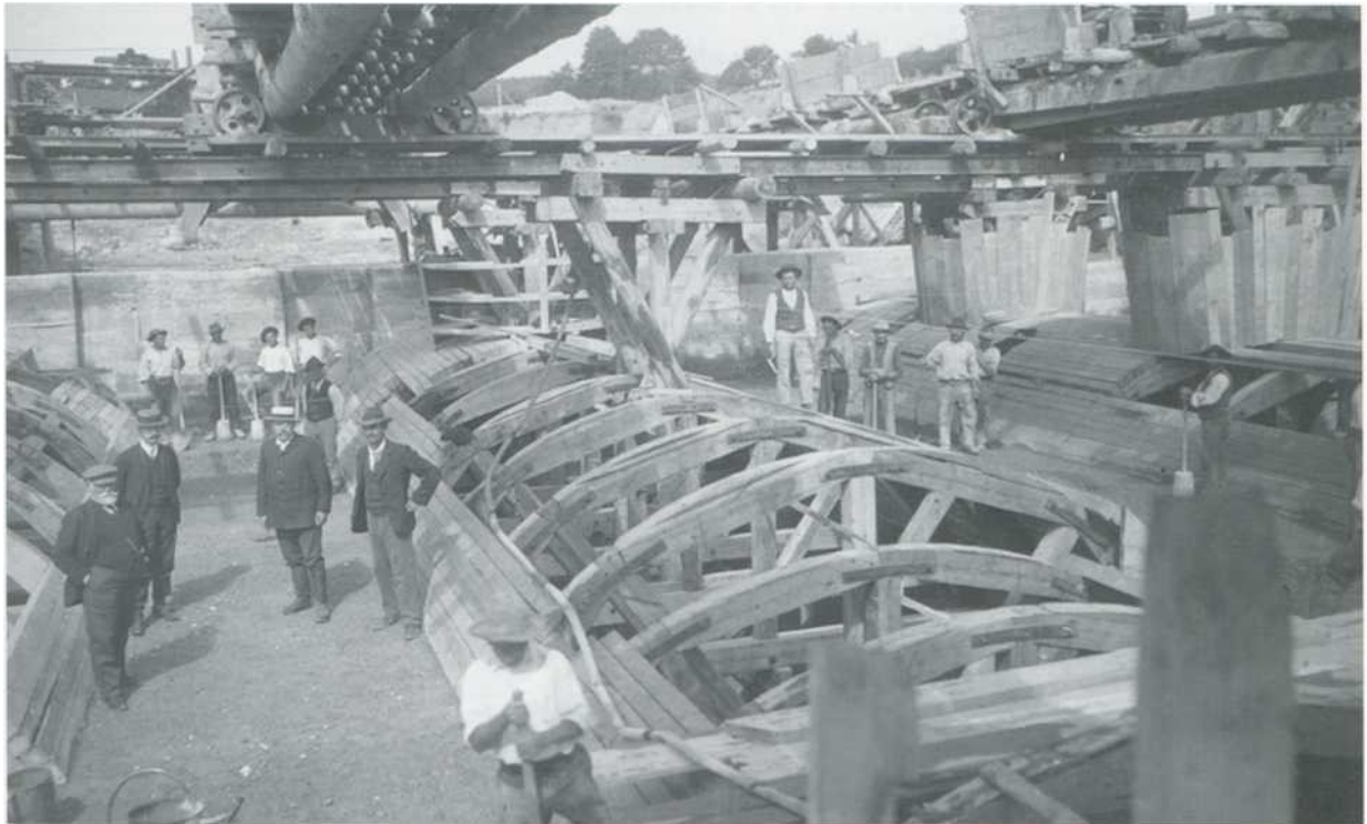
Maschinenhaus, Einschalung und Betonierungsarbeiten der Gewölbe 10. Juli 1903
