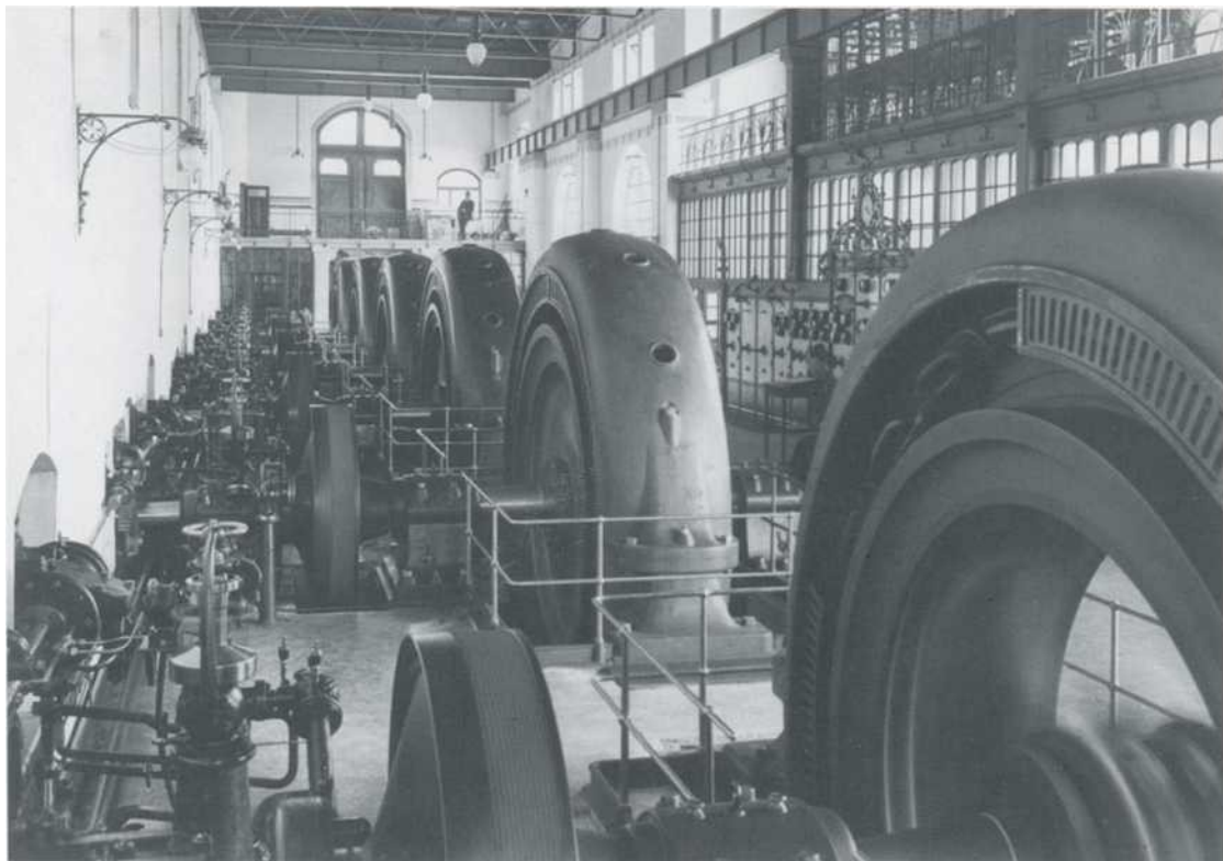
Maschinenhaus, Innenansicht nach Vollausbau 1907
